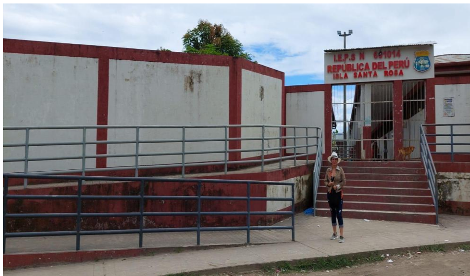
FIGURA 35: Instituição escolar - IE nº 601014 - PE em 20231, Ilha de Santa Rosa Peru
