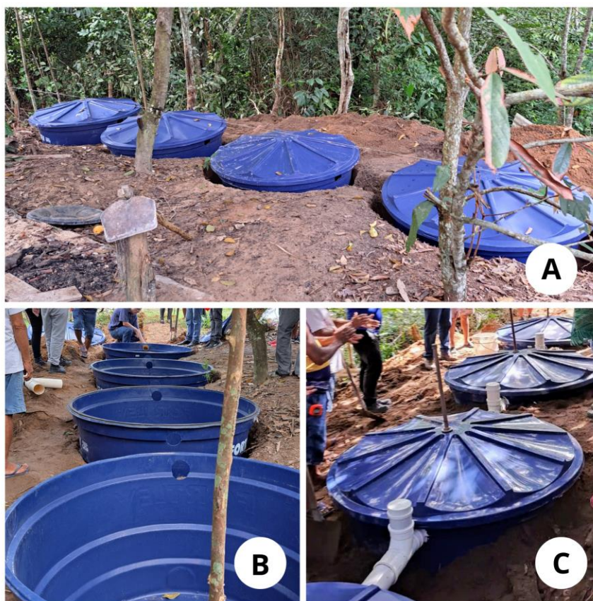
Figura 18 - Instalação da fossa séptica biodigestor
