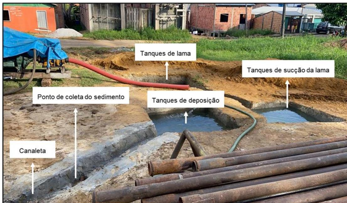
Figura 11: Canaletas que conectam os tanques de deposição e sucção da lama.
