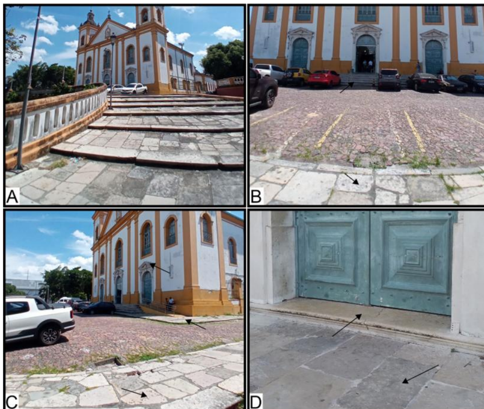
Figura 22 – Formas de ocorrência dos calcários portugueses na porção externa da Catedral Metropolitana de Manaus. A – Escadaria frontal com degraus e espelhos em calcário Lioz. B – Acesso principal e calçada em Lioz. C – Fachadas, calçamento e meio-fio revestidos com Lioz. D – Detalhe do Lioz na calçada e ornamentação do portal.
