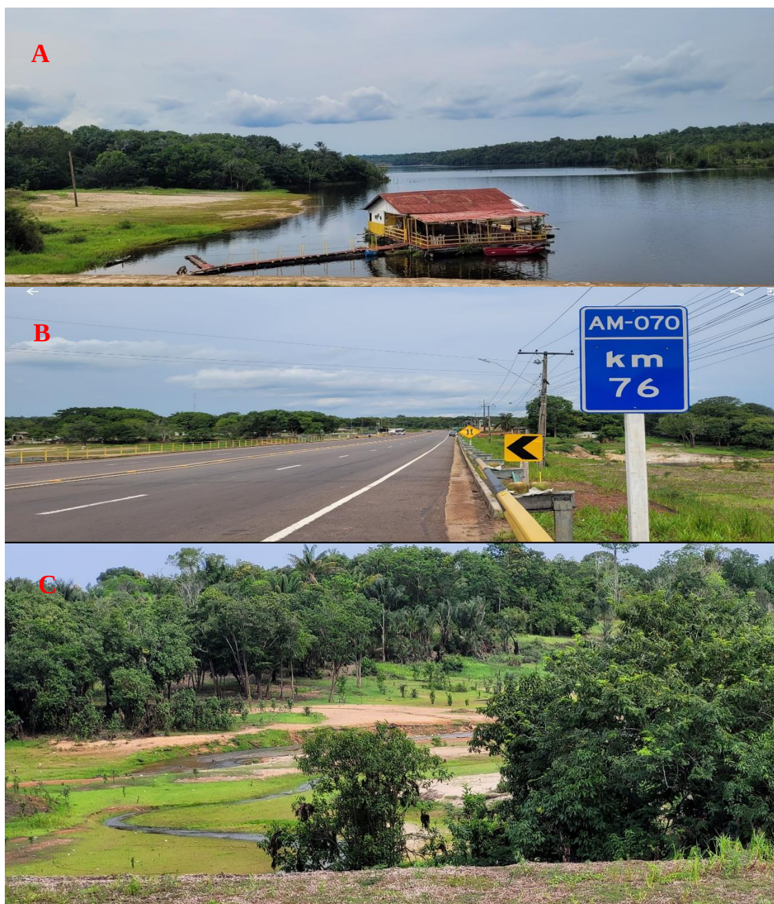
Figura 67 – As duas margens da Rodovia Manoel Urbano (AM -070) sob o igarapé do Miriti
