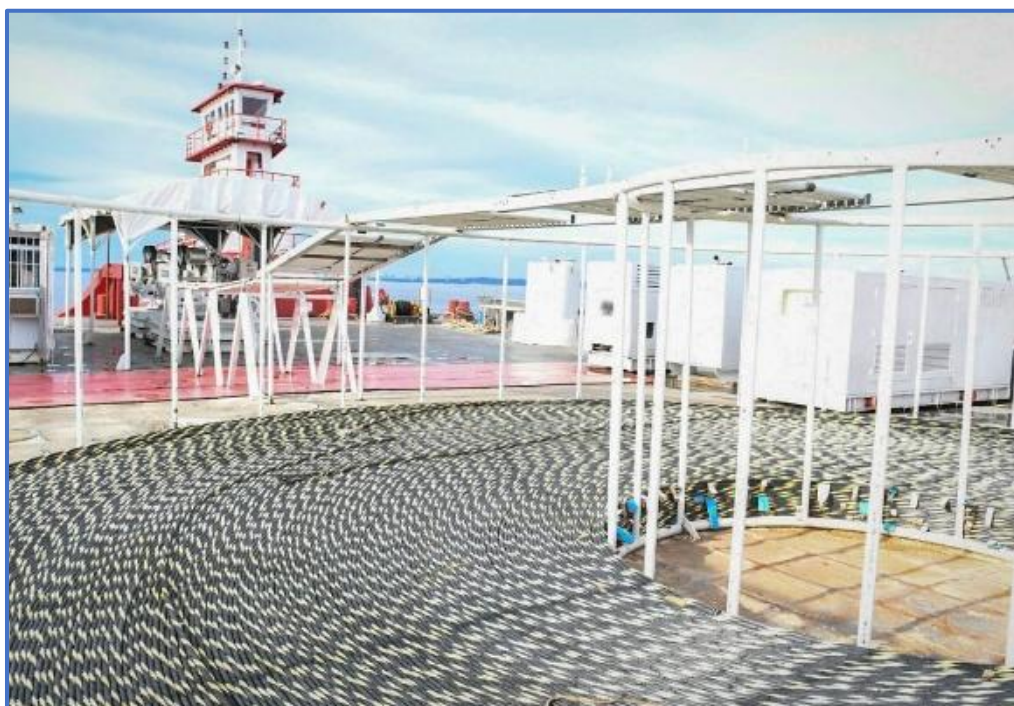
Figura 39 - Projeto Amazônia Conectada: estruturas de cabeamento de fibra óptica das infovias amazônicas
