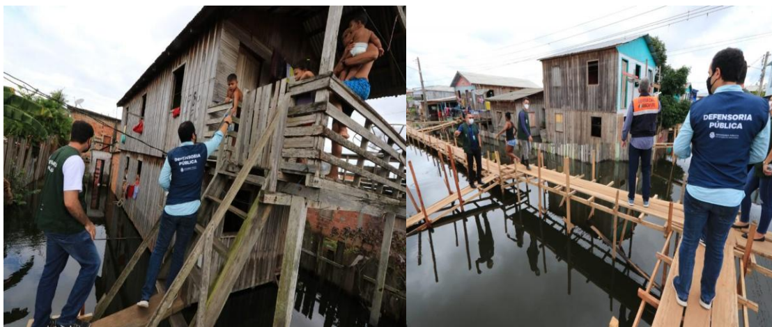
Figura 74 – Ruas em rios e pontes suspensas durante a cheia de 2021 em Bairros de Manacapuru/AM
