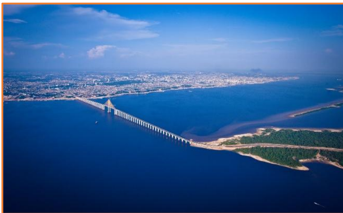
Figura 54 – A Ponte Rio Negro objeto da modernização técnica do território e facilidade de acesso na Região Metropolitana de Manaus/AM
