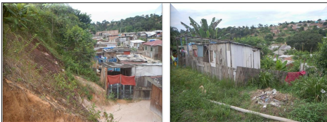
Figura 1. Imóveis em alto e muito alto risco de serem afetados por deslizamentos - Bairro Jorge Teixeira, Zona Leste de Manaus.
