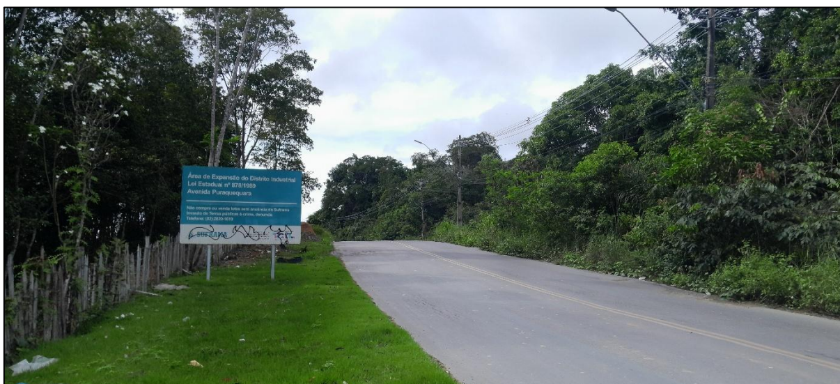
Figura 69. Área de Expansão Avenida Puraquequara, Puraquequara, Manaus - AM.
