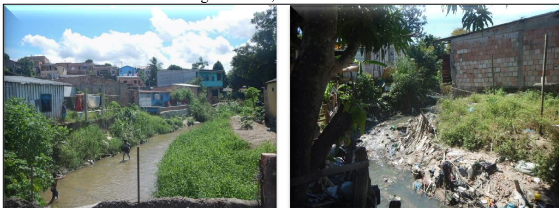
Figura 2. Imóveis em médio risco de serem atingidos por alagamentos, na rua Beira Rio, bairro Jorge Teixeira, Zona Leste de Manaus.
