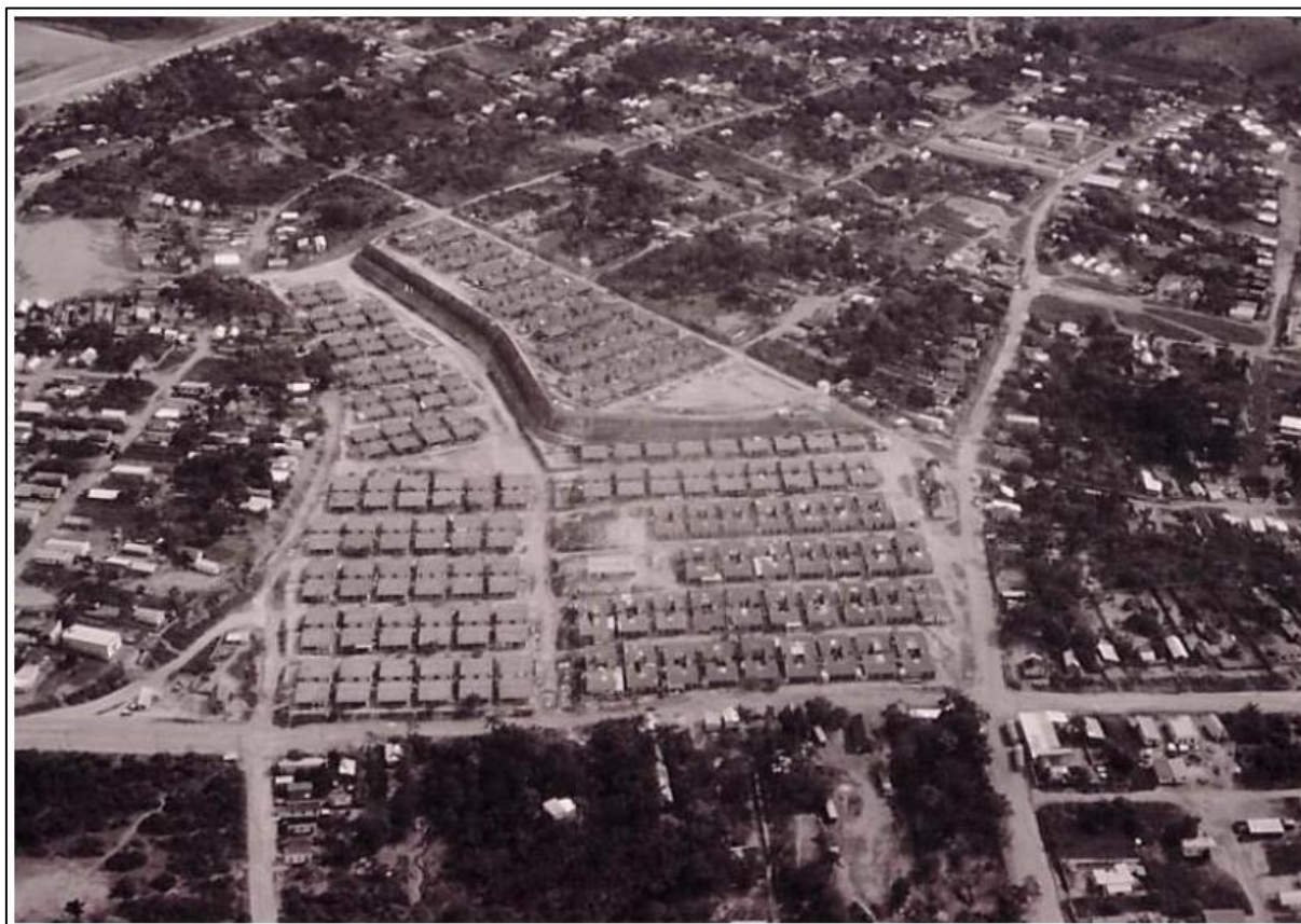
Figura 9. Conjunto Habitacional do bairro da Raiz implantado.
