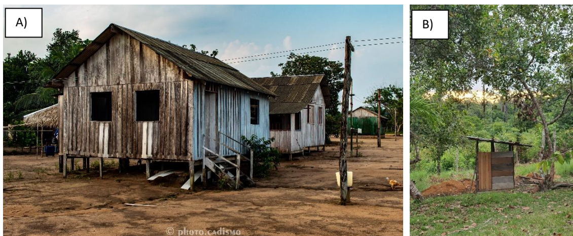
Figura 31. (A) Tipo de estrutura construída para a habitação na região do Alto Urupadi; (B) Banheiro sanitário
