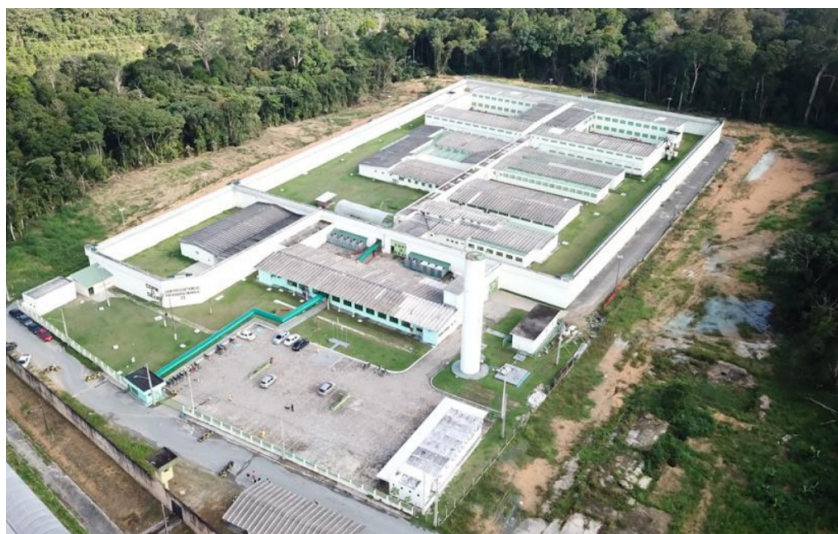
Figura 9: Centro de Detenção Provisória de Manaus II (CDPM II)
