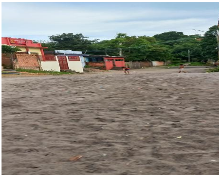
Figura 30 – Condição da rua de areia, moradores sujeitos a poeira e erosão
