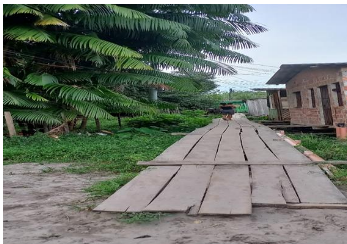
Figura 17 – Passarela improvisada para acesso dos moradores
