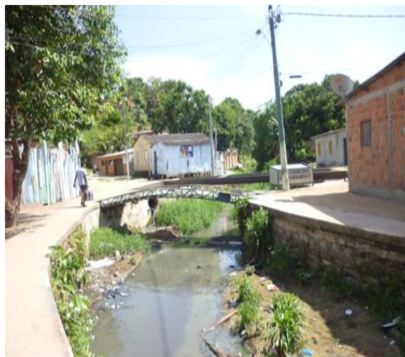
Figura 3 – Rip-rap Zumbi I
