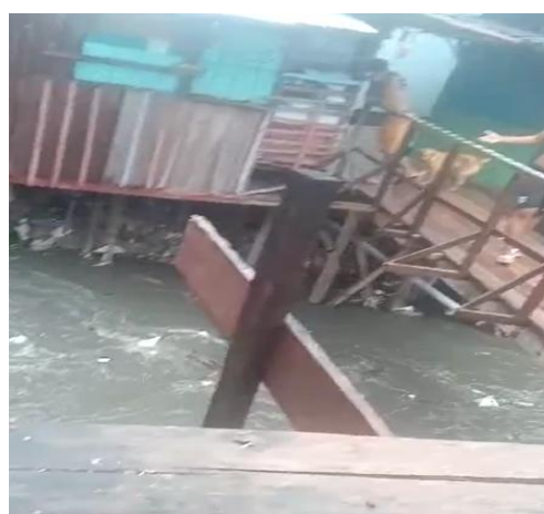
Figura 21 – Ponte que dá acesso a área de estudo setor III
