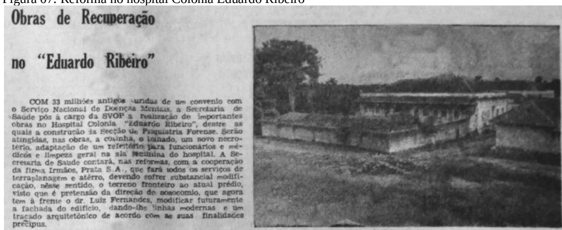
Figura 07: Reforma no hospital Colônia Eduardo Ribeiro
