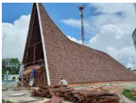
Figura 40. Montagem dos cavacos da igreja em Rio Preto da Eva. Fonte: No Ar (2024).
