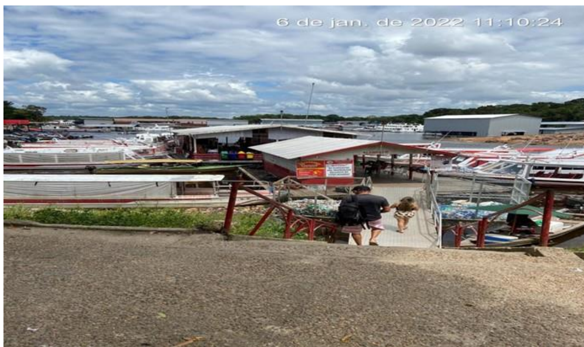
Figura 50 – Conflito com infraestrutura portuária em Marina Pública na BHTA.
