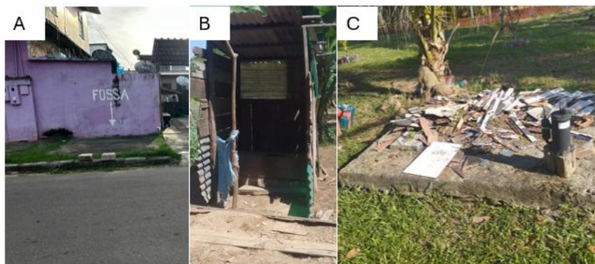
Figura 12. Construções de fossas no município de Itacoatiara. A) Fossa séptica em área urbana; B) fossa rudimentar ou buraco em comunidades C) Fossa séptica em comunidade
