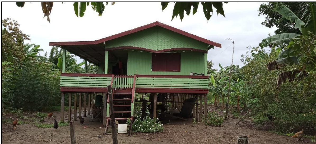
Figura 23: Casa construída em palafitas acima do nível de transbordamento do rio
