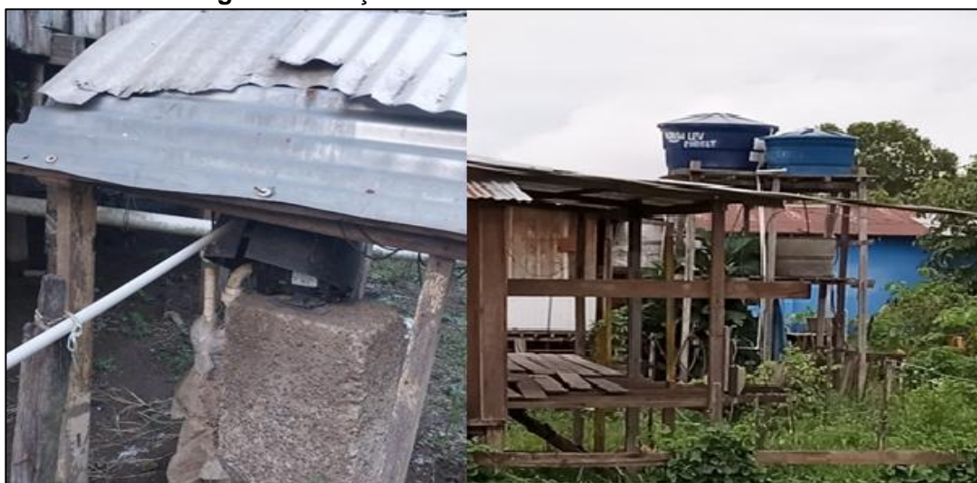
Figura 34: Poço tubular e Caixa de armazenamento
