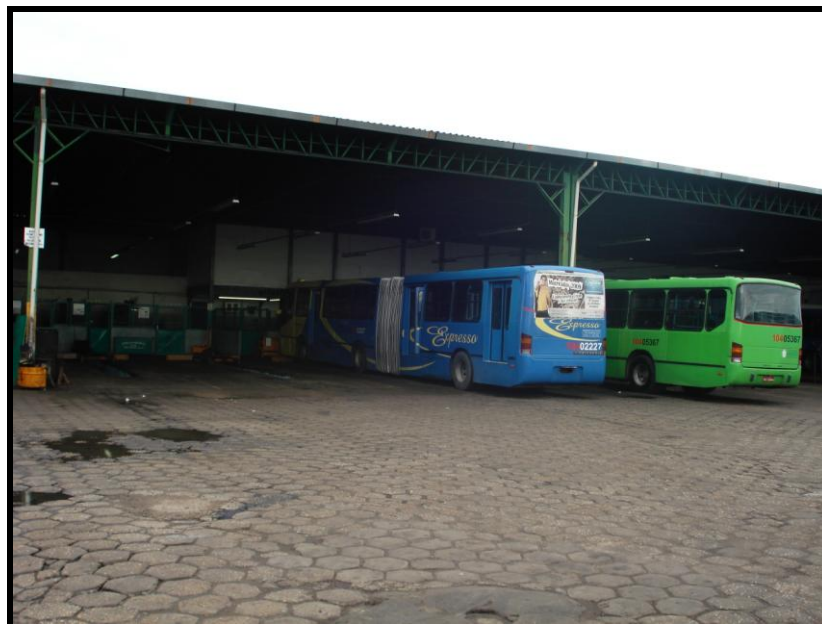
Figura 6 -Garagem da empresa – Setor de Manutenção
