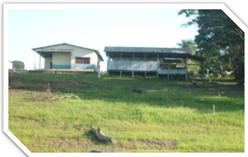
FOTO 1: escola da Comunidade
