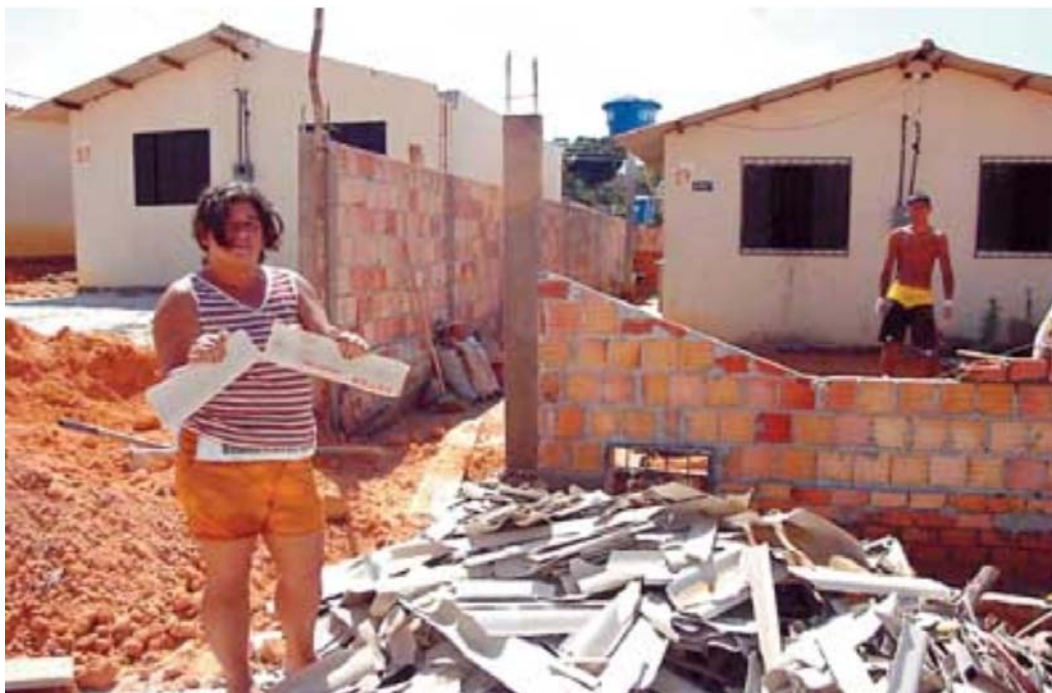
Figura 13 – Conjunto Habitacional Nova Cidade: destelhamento FONTE: Programa de Recuperação de Áreas Degradadas – PRAD Nova Cidade, p. 121, 2004.
