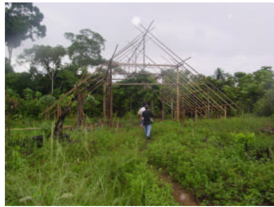
Construção da maloca de Itaquiatiara Mirim, 2007 Foto: Ulisses do V. Oliveira
