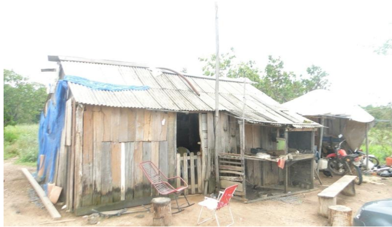
Figura 6 – Casa de trabalhador rural Impossibilitado de Receber Apoio do Governo
