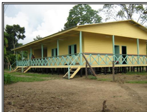
Figura 7: Anexo da Escola FONTE: Marcelo Calegare, Fev/ 2007
