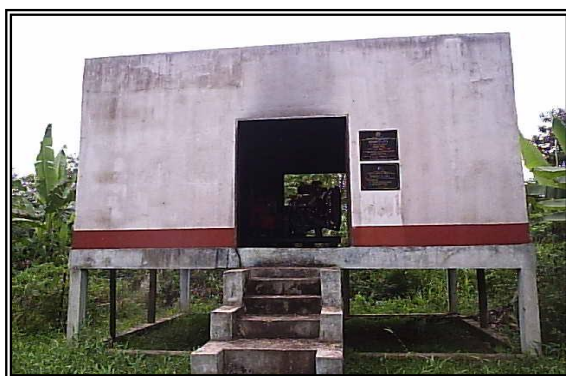
Figura 09: Gerador de Energia. FONTE: Francenilda Oliveira. Fev/2007
