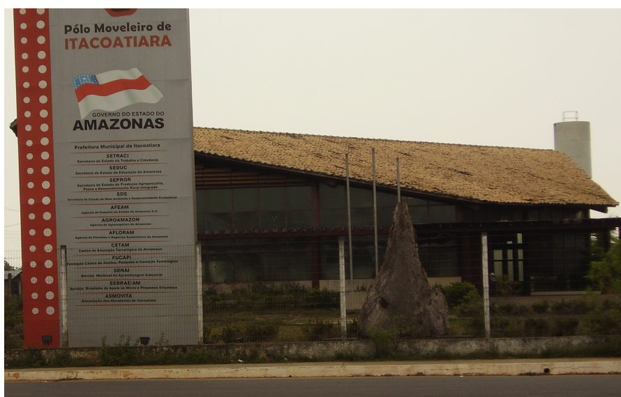
Figura 23 – Prédio do Pólo Moveleiro. FONTE: Foto CNSO, 2006.
