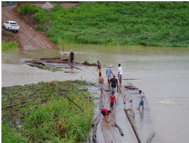
Figura 5 – Homens trabalhando na construção da ponte.
