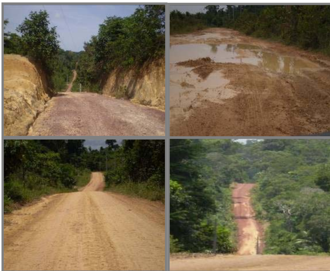
Figura 4-Ramal principal e vicinais da comunidade do Pau Rosa. Fonte: Nogueira, A. C. F.
