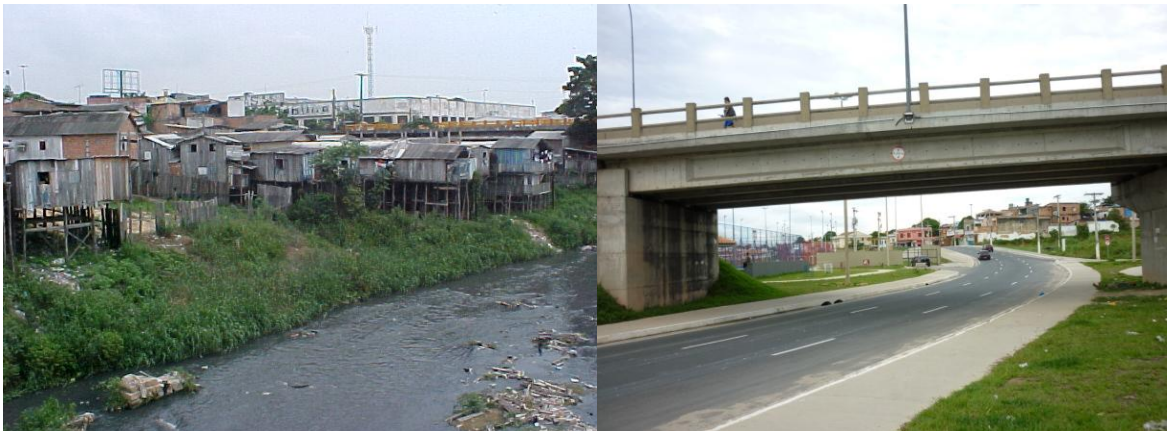
Figura 19 – Passagem inferior São João e Anti-Mary no bairro da Cachoeirinha antes e depois da intervenção. Fonte: UGPI, 2009-2010.
