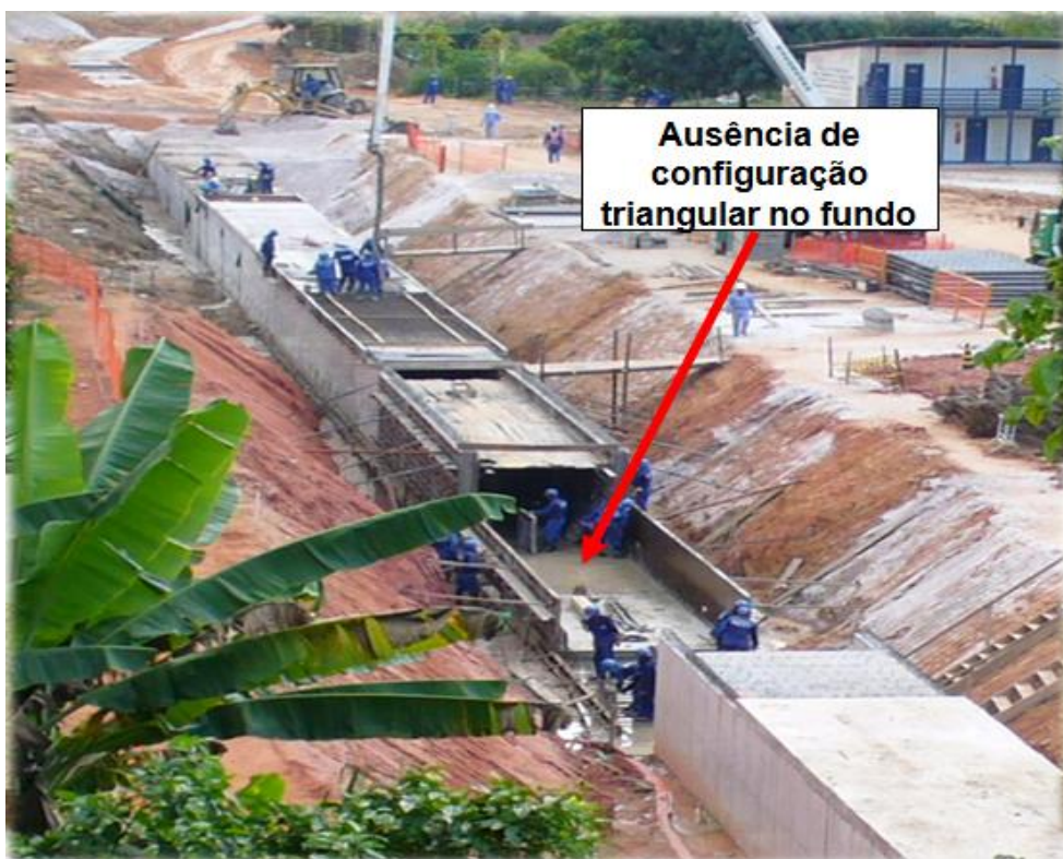
Figura 3 – Execução de macrodrenagem para criação de solo para implantação de um conjunto habitacional do PROSAMIM.
