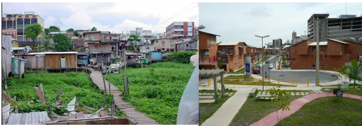
Figura 2 – Igarapé Manaus: condições de moradia e pontes de madeira que interligam as palafitas, antes e depois da intervenção do PROSAMIM. Fonte: UGPI (2003-2007)
