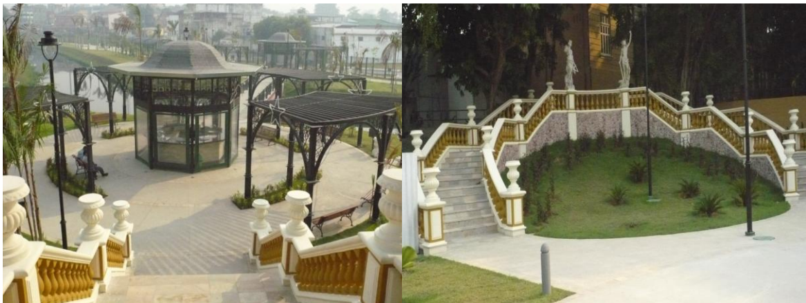
Figura 18 – Imagens do mobiliário urbano do Parque Senador Jefferson Peres depois da intervenção. Fonte: UGPI
