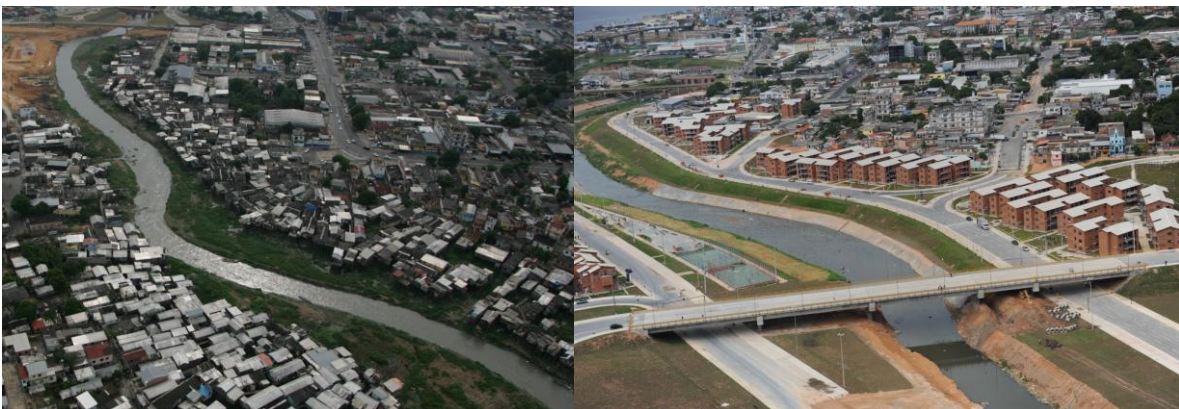
Figura 22 – Vista aérea do igarapé antes e depois da intervenção e da construção de unidades habitacionais. Fonte: UGPI, 2009-2010
