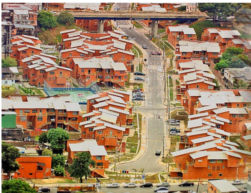
Figura 15 – Imagens do Parque residencial Prof. José Jefferson Carpinteiro Peres localizado no antigo Igarapé de Manaus depois do solo criado pela intervenção para construção de unidades habitacionais, que representam a produção em série afirmada por Le Corbusier (2009)
