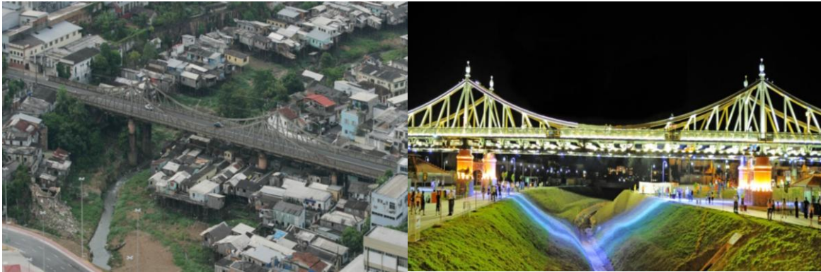
Figura 20 – Ponte Benjamin Constant que liga o centro da cidade ao bairro da Cachoeirinha antes e depois da intervenção do PROSAMIM. Fonte: UGPI, 2009-2010
