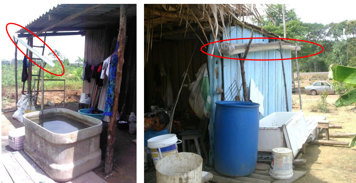
Figura 58 – Captação de água da chuva para consumo humano na comunidade Fé em Deus FONTE: Banco de Imagens do Grupo Água e Comunidades / Projeto PIRAHIBA
