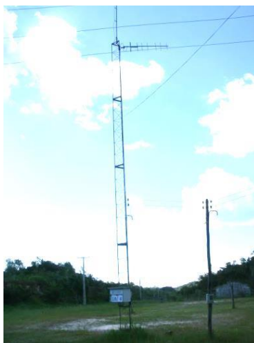
Figura 57 – Antena da telefonia local, Ramal Principal da comunidade Fé em Deus
