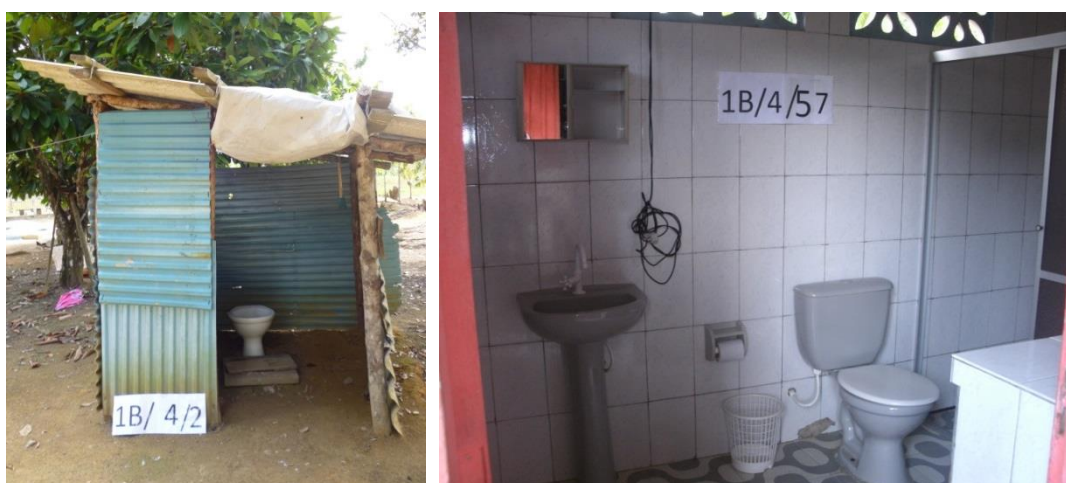
Figura 63 – Exemplos de banheiro fora e dentro de casa na comunidade Fé em Deus
