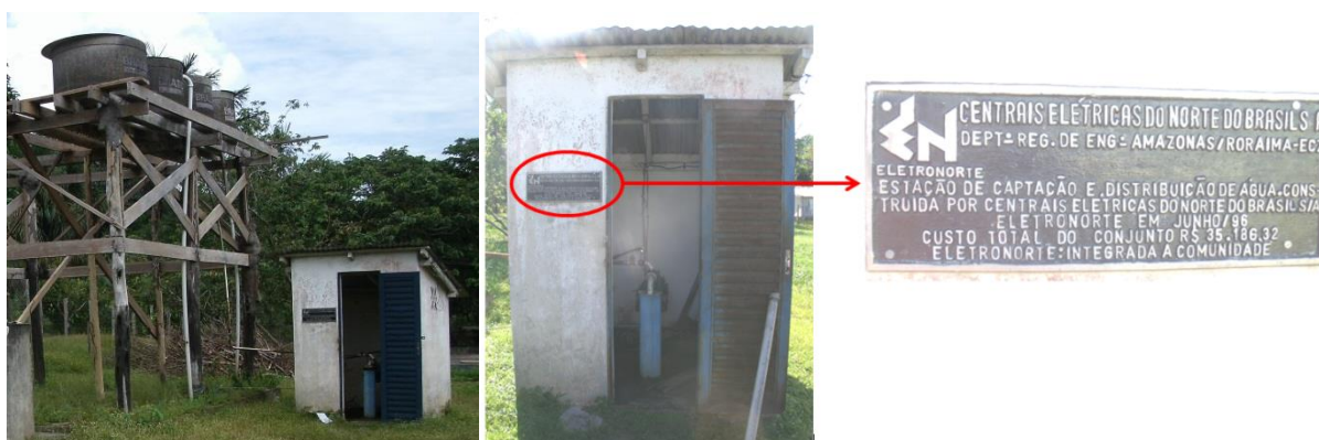
Figura 55 – Poço construído pela Eletronorte na comunidade Fé em Deus
