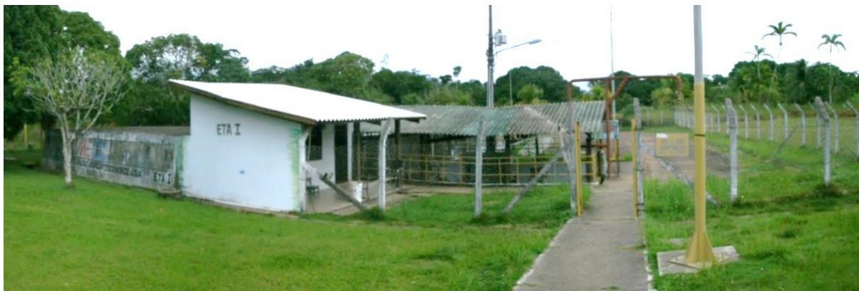
Figura 45 – Estação de Tratamento de Água da Vila de Balbina FONTE: Banco de Imagens do Grupo Água e Comunidades / Projeto PIRAHIBA
