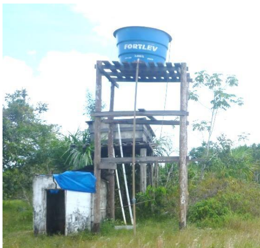
Figura 56 – Poço localizado no Ramal Principal da comunidade Fé em Deus
