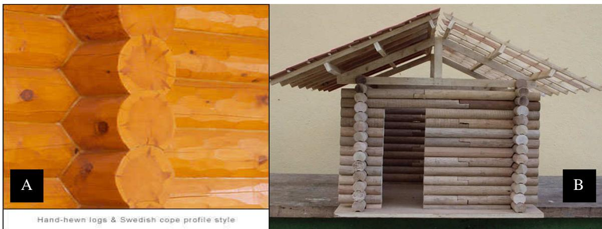
Figura 11. (A) Detalhe construtivo da parede de uma “Log Home” pelo Método Sueco (Swedish Cope). (B) Maquete de uma edícula com paredes de rolo-resto.
