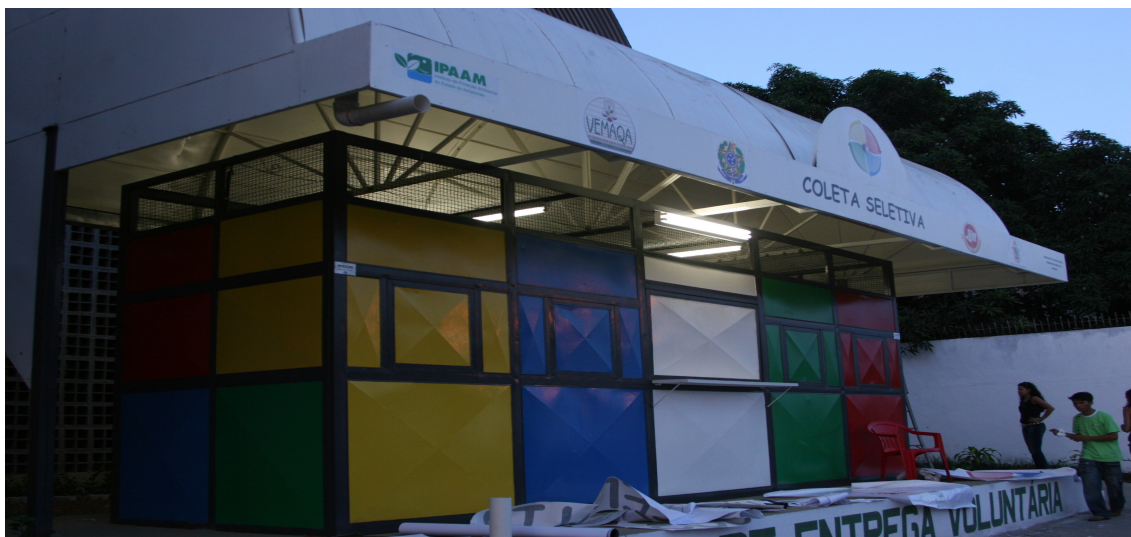
Figura 7: Ponto de Entrega Voluntária (PEV) na Praça de Alimentação do Conjunto Habitacional Dom Pedro I.
