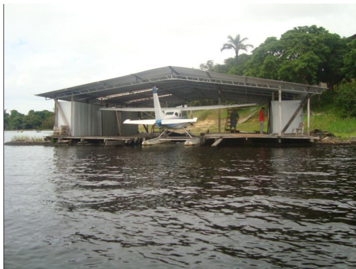
Figura 16: Hangar flutuante, localizado entre os igarapés da Colônia e da Lenha Fonte: Mario Jorge Ribeiro Filho
