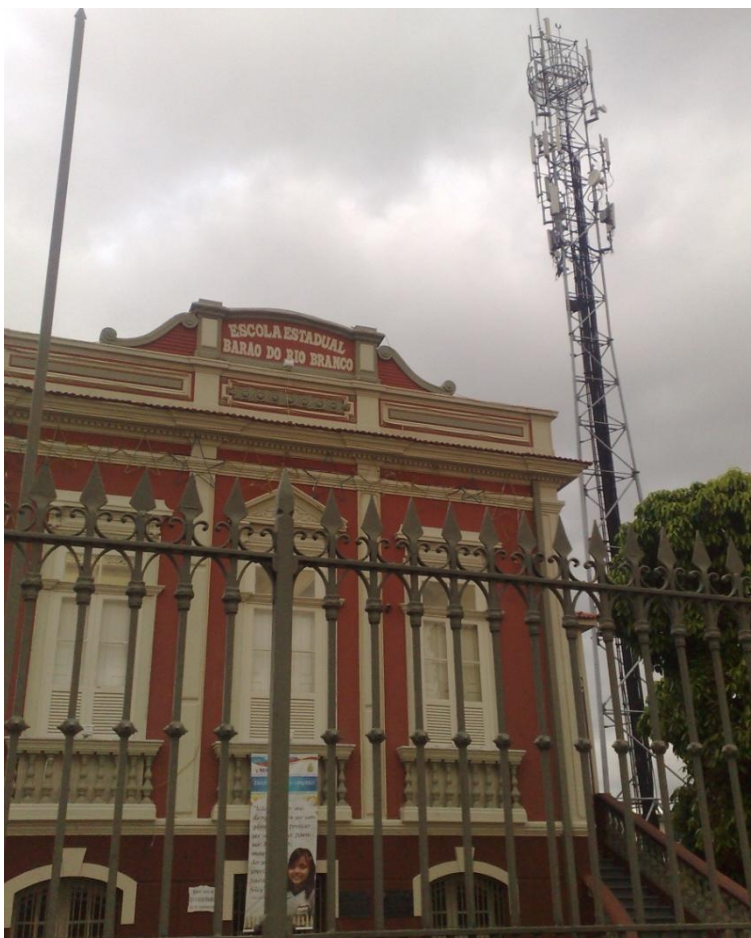
Figura 10. Torre localizada nas proximidades da Escola Barão do Rio Branco na Av. Joaquim Nabuco (TORRE 09), no centro, Manaus, AM.
