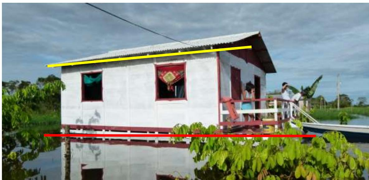
Figura 46. Na imagem a linha vermelha delimita a altura do barrote e a amarela o limite do esteio (se houvesse).
