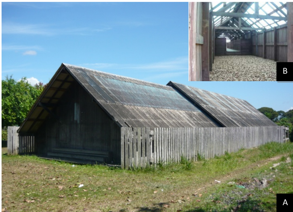
Figura 13 – A - Paiol central de secagem e armazenamento de castanha construído na comunidade Democracia. B – detalhe do interior do paiol
