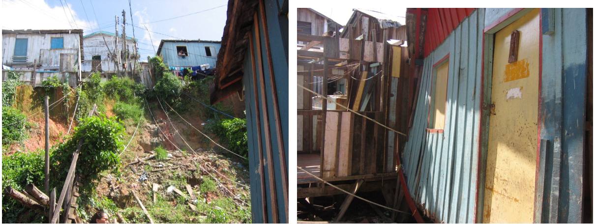
Figura 16 e 17 – Vista do barranco e de uma moradia da base da encosta após um deslizamento de terras
