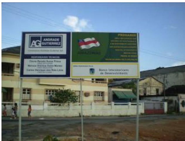
Figura 2 – Placa de obras no igarapé Bittencourt FONTE: PINHEIRO, 2007.
