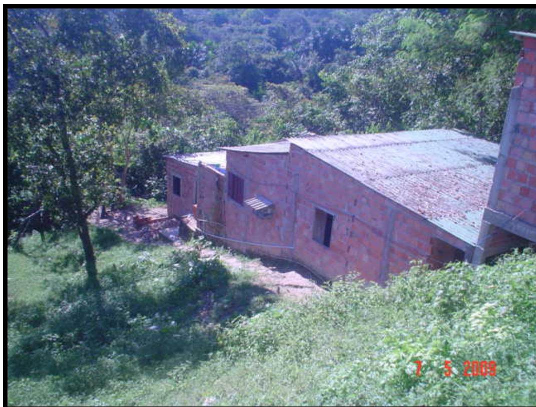
Figura 18. Moradia irregular, Rua 47, Zona Leste da borda do Parque Estadual Sumauma-2009
