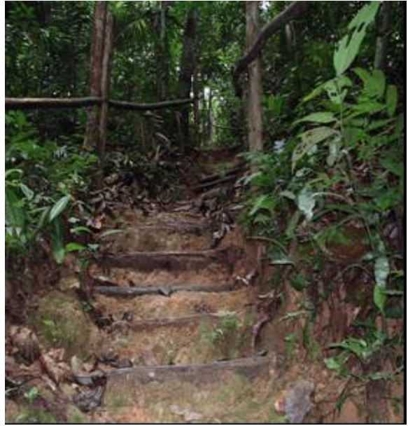
Figura 9 - Trilha: contenção da erosão FOTO: Eloisa Gadelha, 2005.
