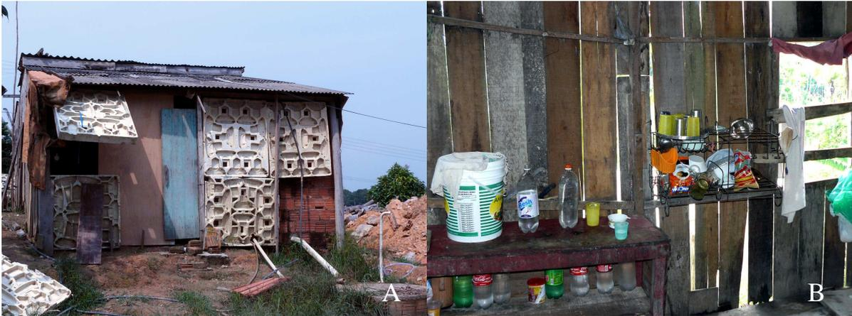
**Figura 12** – (A) Casa com peças de isopor e (B) Espaços na parede de madeira na moradia visitada, ambas nas localidades do entorno sul da RFD, Manaus/2008.
