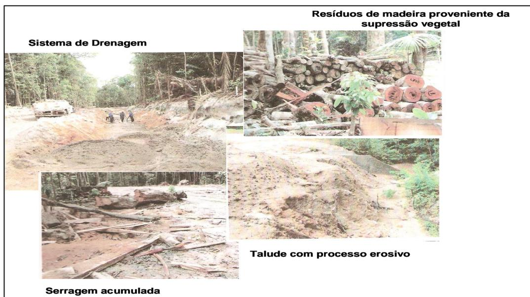
**Figura 17** - Impactos causados durante a fase de implantação do Loteamento AlphaVille Manaus I, 2006/2007
