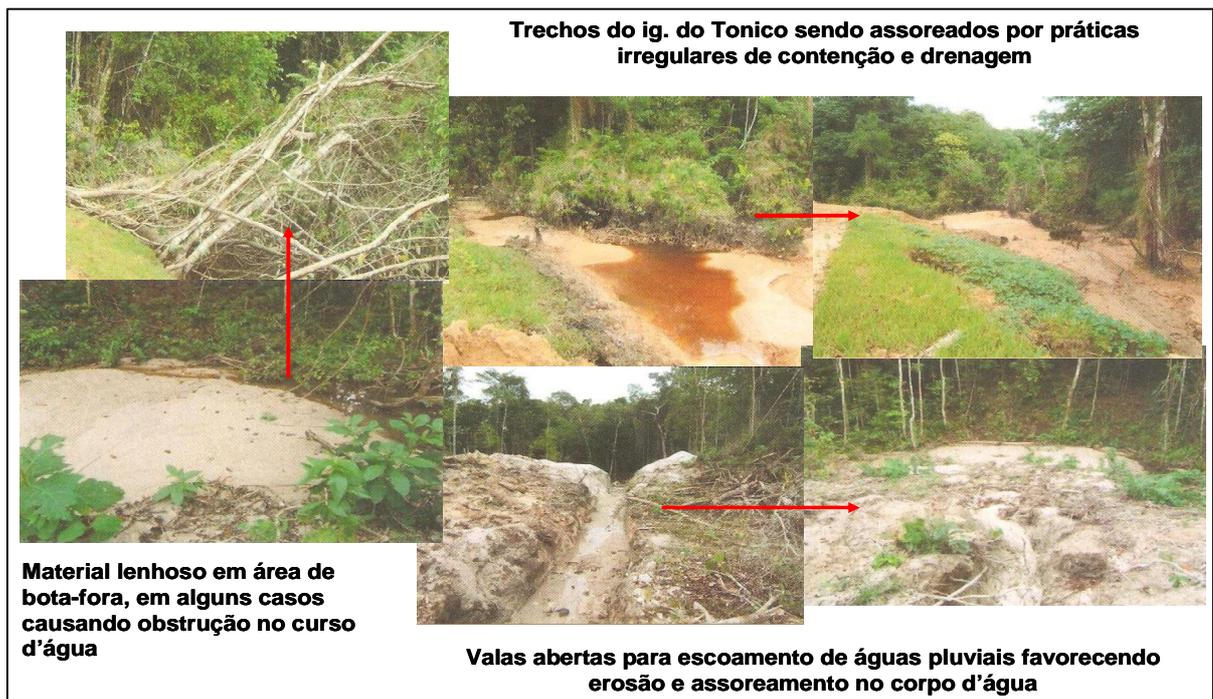
**Figura 19** – Impactos causados durante a fase de implantação, 2008
