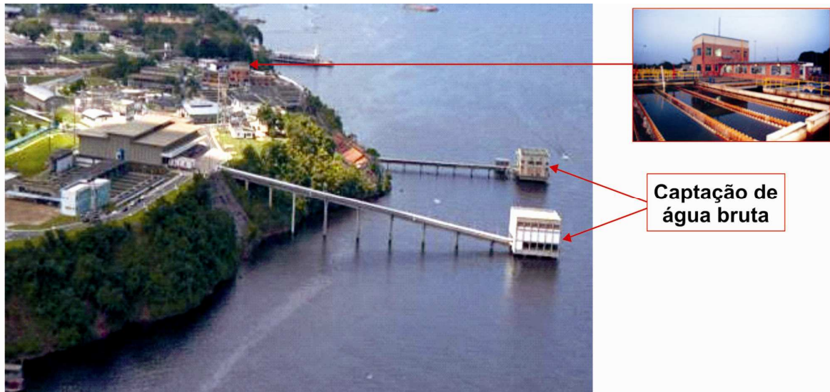
Figura 07 - Sistema Ponta do Ismael de captação de água do rio Negro para abastecimento de Manaus.
