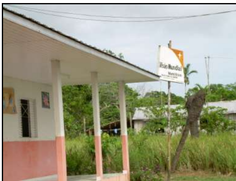
Figura 36 – Escola São José – Escola reformada da comunidade São Tomé. Fonte: TEIXEIRA, Lorena (2006)
