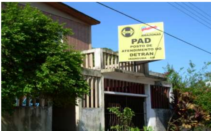
Figura 16 – Prédio onde funcionam a Secretaria de Meio Ambiente e Turismo, a Junta Militar e o Posto de Atendimento do DETRAN. Fonte: TEIXEIRA, Lorena (2006).
