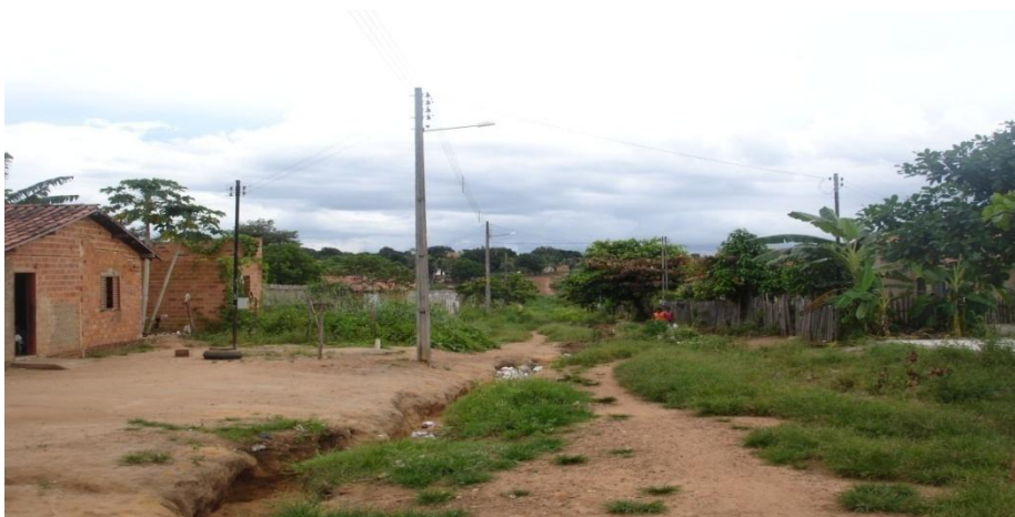
Figura 5 – Ausência de pavimentação no Setor Santa Rosa I – Bairro de Colinas do Toc.-TO Fonte: Erivelton S. Costa
