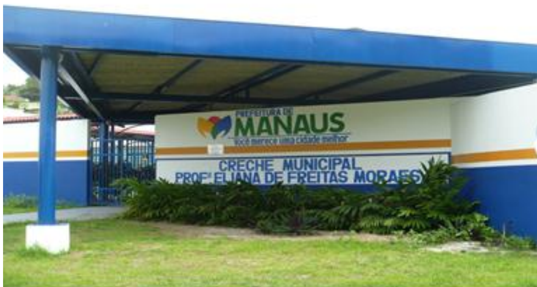
Foto nº. 1 Fachada da Creche Municipal Profª Eliana de Freitas Moraes/ Manaus 2012. Fonte: Arquivos Fotográficos da Creche Municipal Profª. Eliana de Freitas Moraes
