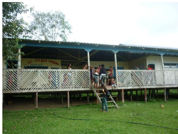
Figura 05: Fachada da escola da comunidade de São Lázaro. Fonte: Andrade, pesquisa de campo 2011.
