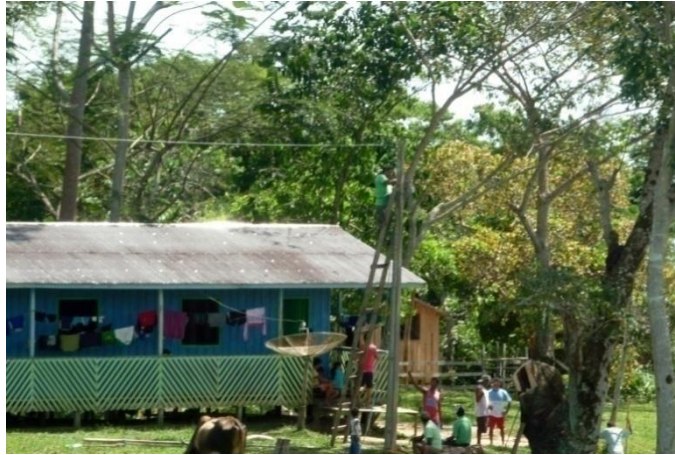
Figura 07: Organização dos moradores para instalar os postes e rede de fiação elétrica na comunidade.
