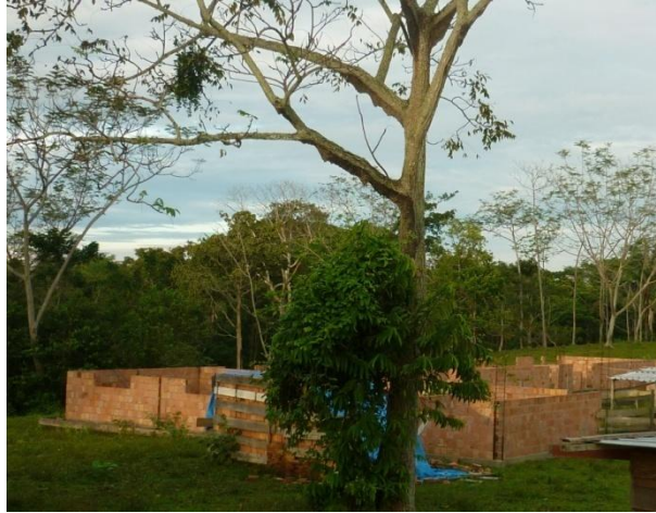
Figura 06: Estrutura da escola da comunidade Bela Conquista em construção Fonte: Andrade, pesquisa de campo 2011.
