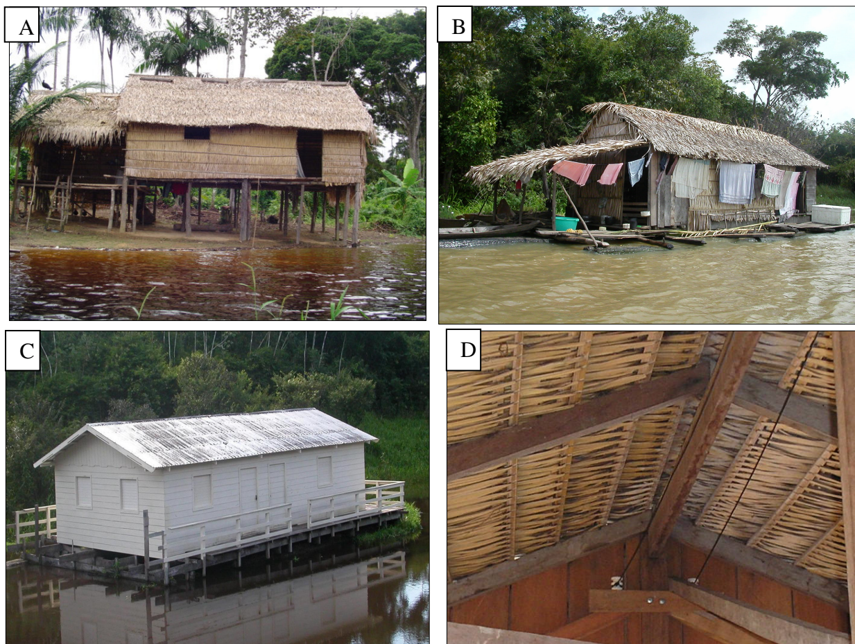
Figura 8. (A) Casa construída com palha na Comunidade Divino Espírito Santo; (B) Flutuante com cobertura de palha; (C) Casa flutuante com cobertura de alumínio; (D) Estrutura dos telhados construídos com palha.
