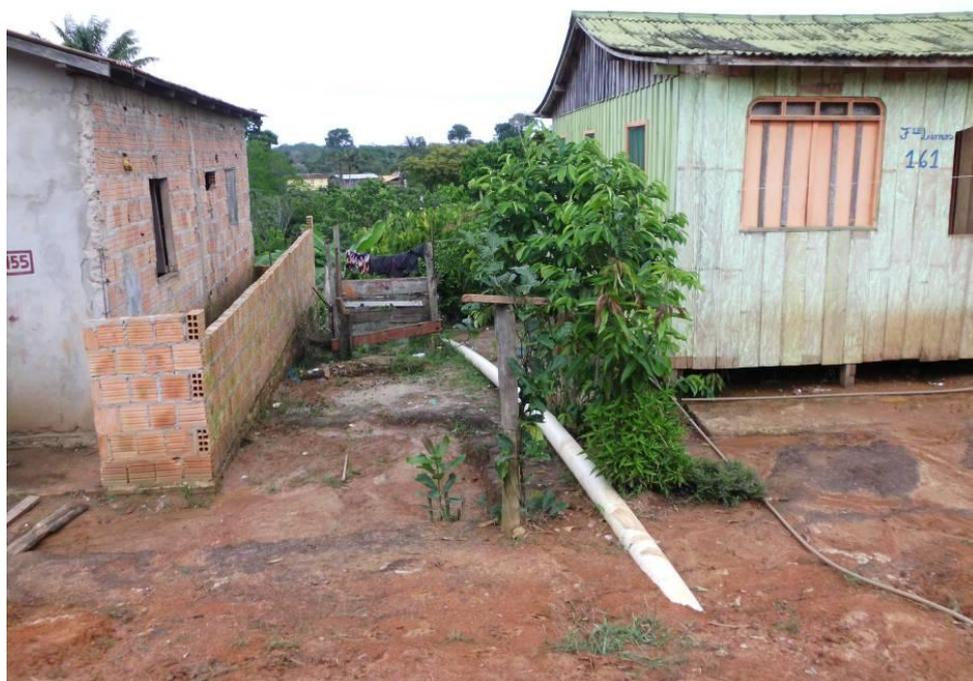
**Figura 14 :** Tubulação exposta de esgoto a céu aberto no Bairro Liberdade. **Fonte:** Santana, P.V. (2013). Acervo NEPECAB.
