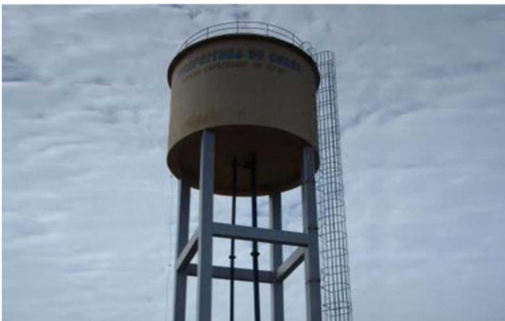
**Figura 18:** Caixa d'água de um poço artesiano. **Fonte:** Plano Diretor Participativo de Coari (2007).
