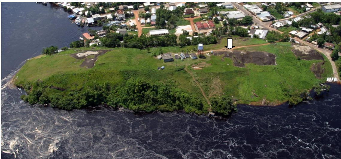
Figura 16 - Morro da Fortaleza. Foto Brigada Aérea SGC, 2006.
