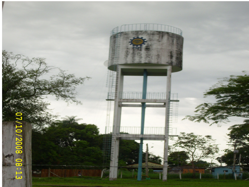
Figura 23- Abastecimento de Água - Vila Amazônia FONTE: Pesquisa de Campo, 2008 (Foto de Charlene Muniz).
