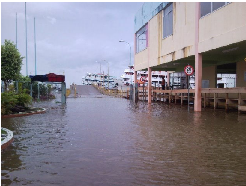
Figura 4 – Estrutura do porto que foi invadida pelas águas FONTE: Arquivo pessoal de Reandro Azedo (junho de 2009).
