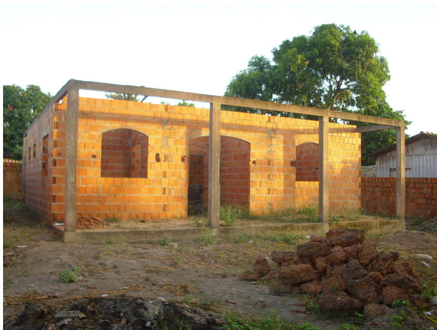
Figura 33: Casa de alvenaria sendo construída -Mocambo FONTE: Pesquisa de Campo, 2009 (Foto de Charlene Muniz).
