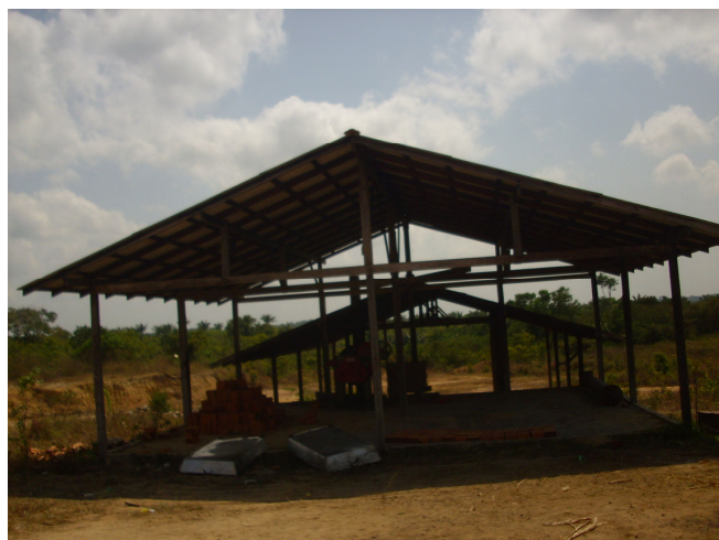
Figura 62- Local onde é moído a cana-de açúcar e onde se pretende construir uma fábrica de açúcar mascavo - Caburi FONTE: Pesquisa de Campo, 2009 (Foto de Charlene Muniz)
