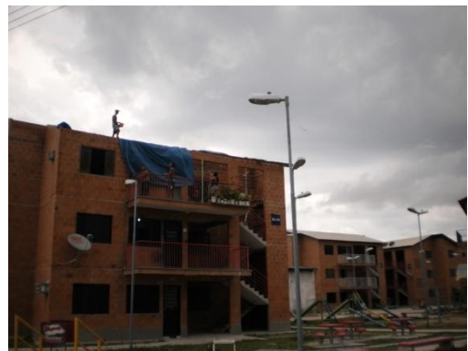
Figura 12: Destelhamento PRGM. Fonte: Meneghini, 2011.
