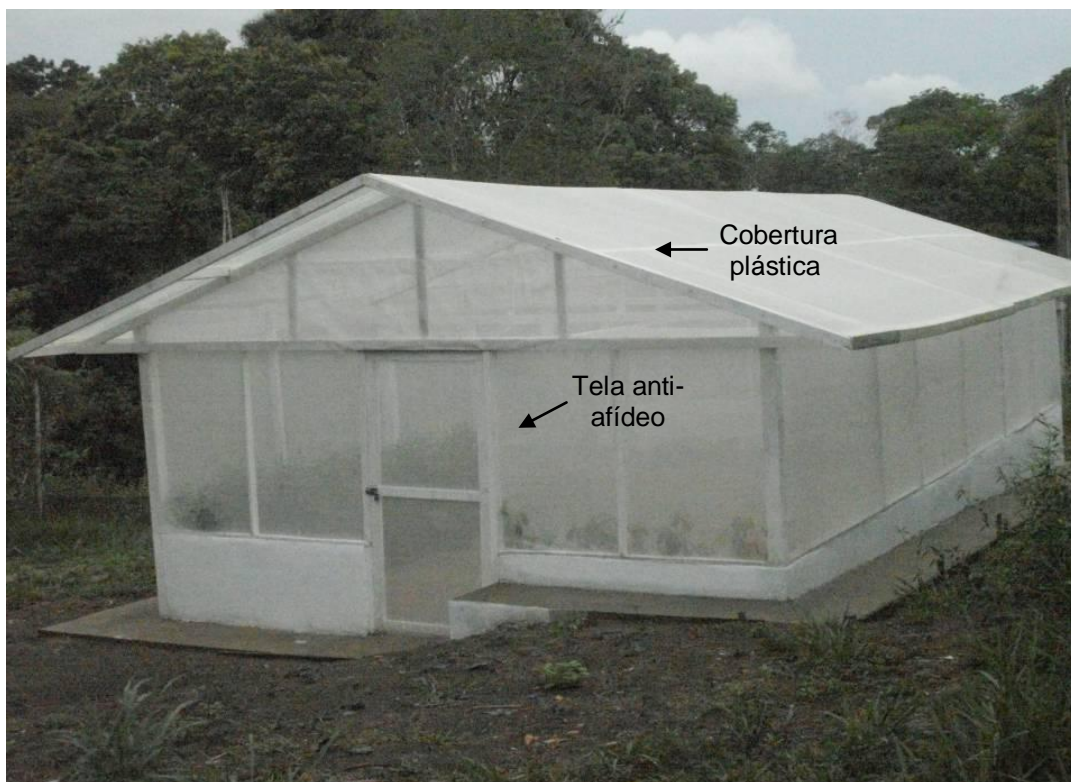
Figura 8- Casa de vegetação utilizada para a produção de pimentão. Foto: Raquel Corrêa.
