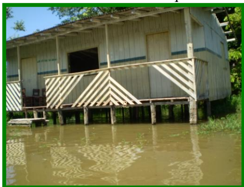
Figura 10 Prédio Escolar – Piquiá
