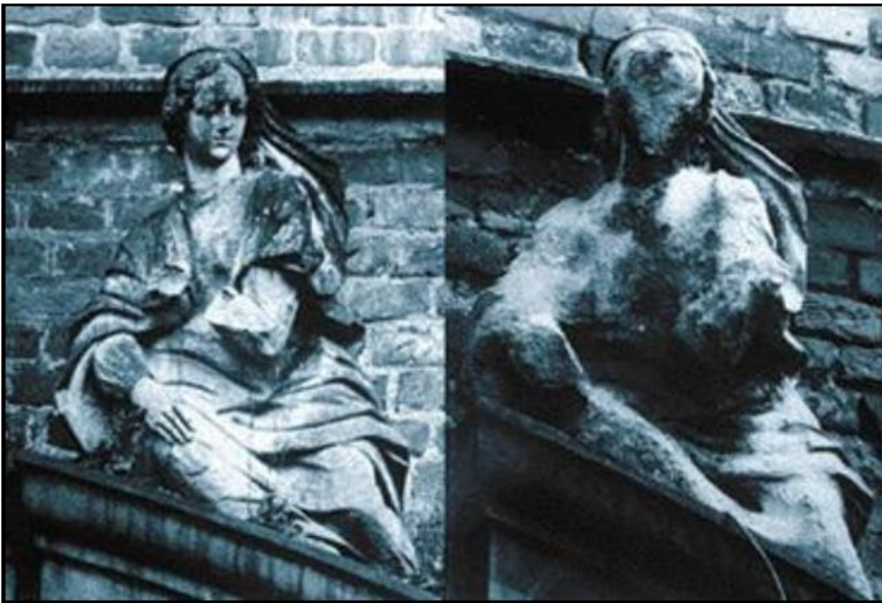
Figura 3 - Desgaste de uma estátua devido a chuva ácida FONTE: Adaptado de PIRES, 2005
